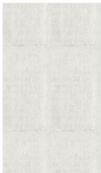
Betonwände Schalungstyp 2, hell lasiert
