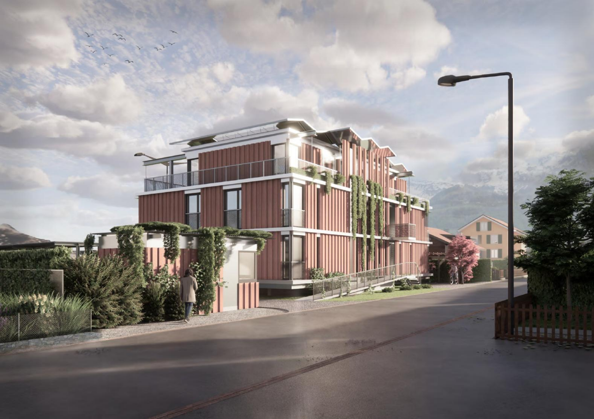
Bild: Ansicht Pizolstrasse (Hofladen und Haus) – Richtung Pizol
